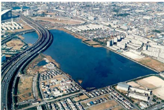
谷津干潟全景（京葉測量株式会社提供）
